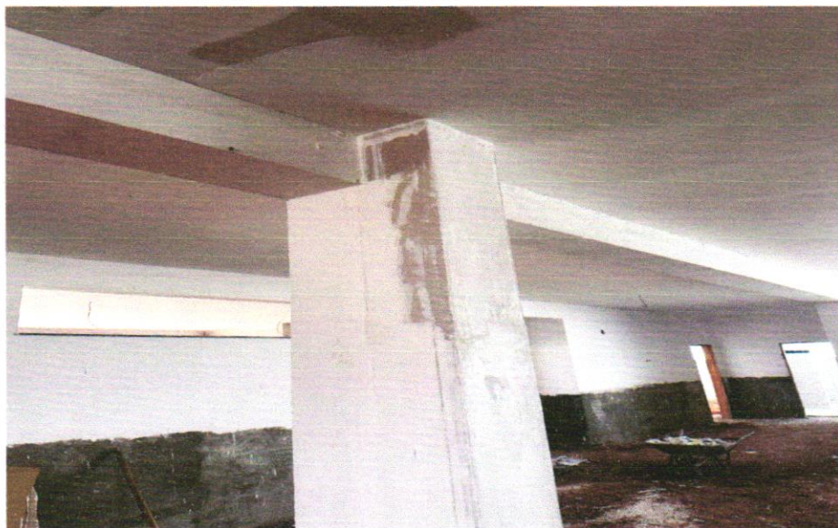
FOTO 201: PAREDE DE DRYWALL
