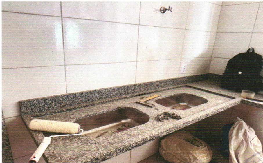
FOTO 206: INSTALAÇÃO CUBA INOX
