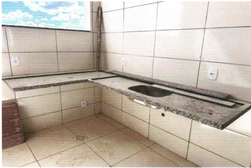
FOTO 207: INSTALAÇÃO BANCADA E CUBA INOX
