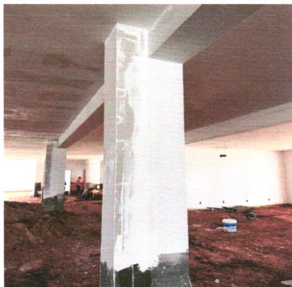
FOTO 202: PAREDE DE DRYWALL
