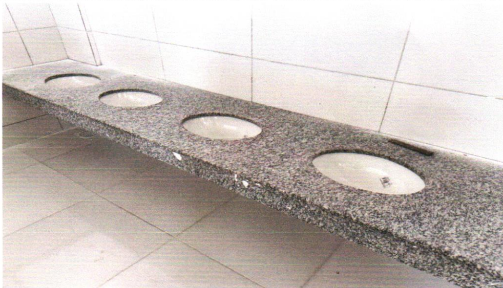
FOTO 208: INSTALAÇÃO BANCADA E CUBA DE LOUÇA
